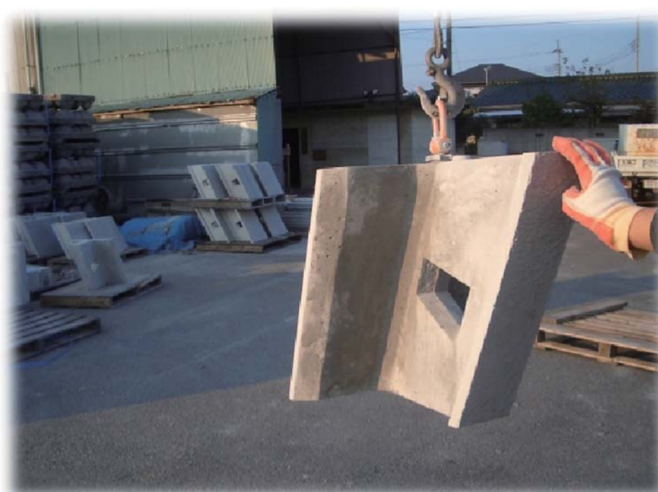
簡易吊金具使用
