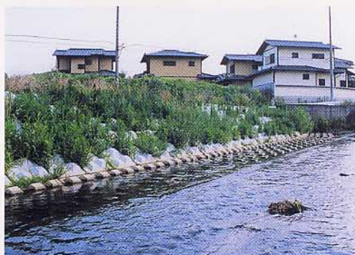
茨城県 桜川広域河川工事
