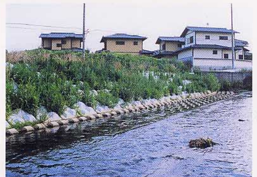
茨城県 桜川広域河川工事
