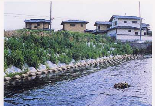
茨城県 桜川広域河川工事
