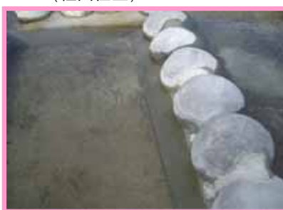
スロープ部コンクリート打設 (粗面仕上)
