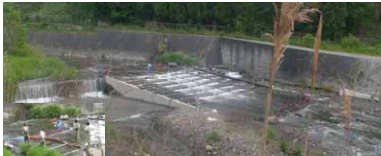
調査箇所全景
