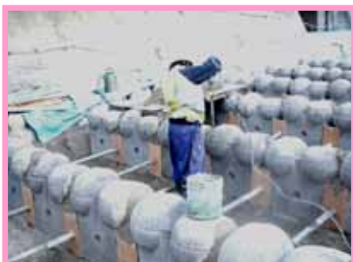
胴込コンクリート打設
