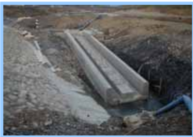
胴込コンクリート打設
