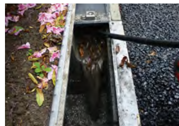
柵に集まってきたゴミは、工具を使用して清掃します。
