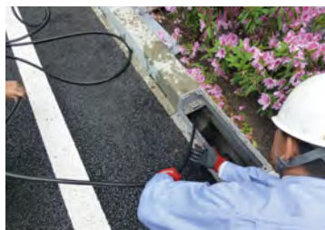
縁石柵から高圧洗浄機で清掃します。
