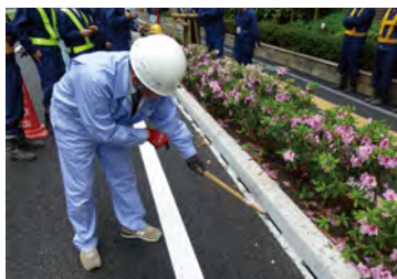
スリットの清掃は、工具を使用して行います。(※高圧洗浄による清掃も可能)
